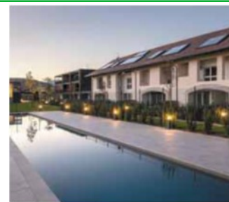
Uno dei progetti realizzati in Alto Adige. Quello in foto è il complesso Riel a Bolzano
